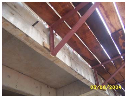
Figura 6. Montagem típica de bandejas de periferia.
