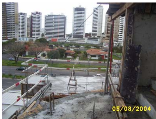
Figura 3- Solução típica de guarda-corpo nas construções
