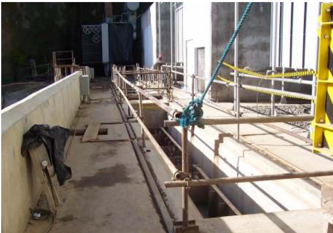
Figura 09 - Guarda-corpo provisório em tubos de aço
