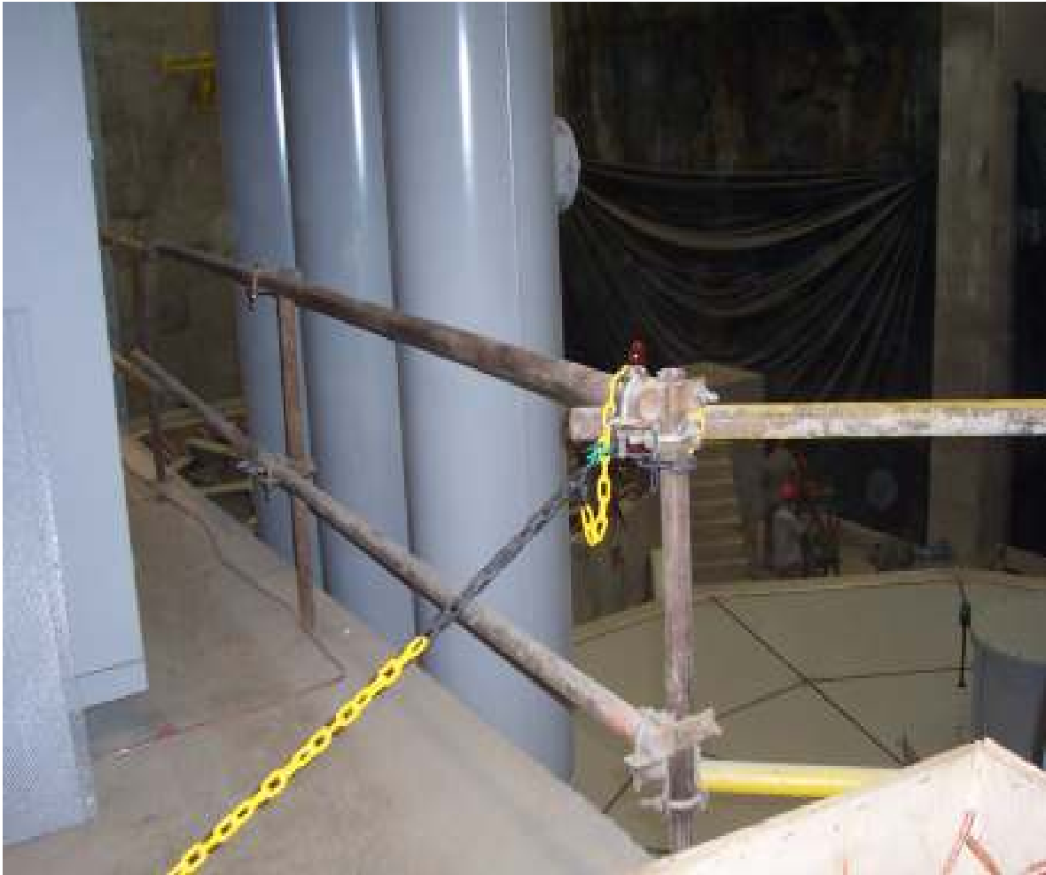
Figura 10 - Guarda-corpo provisório em tubos de aço
